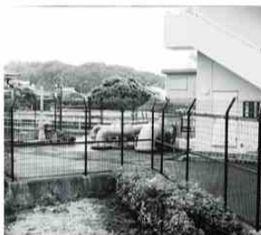
西本屋開ポンプ場
